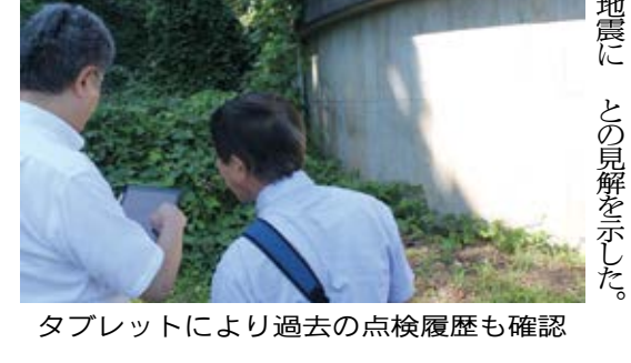
タブレットにより過去の点検履歴も確認
