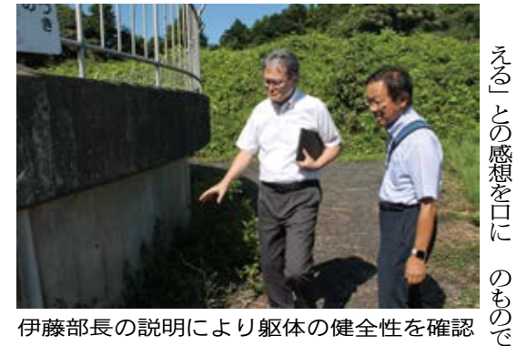
伊藤部長の説明により躯体の健全性を確認
