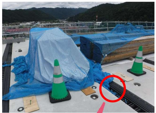
資材にはネットがしっかりと被せられており、ネットは間詰の鉄筋に括り付けてありました！飛散養生が徹底されています。
